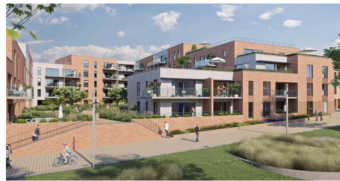
Esprit Courbevoie est situé à l'entrée de Louvain-la-Neuve. C'était le dernier grand espace disponible dans la partie est de la cité universitaire. Une fois achevé, le projet offrira près de 472 nouveaux appartements. © DR
